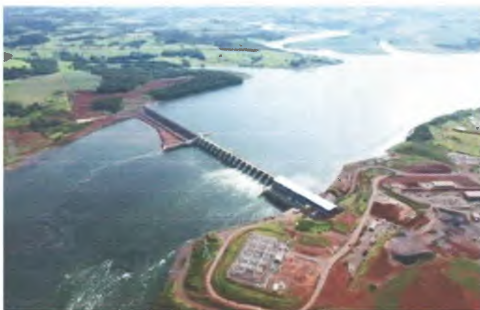
Fonte: Usina Hidroelétrica Baixo Iguaçu
